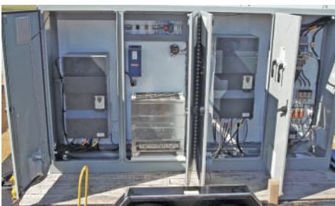
**PANEL DEL ARRANCADOR DEL MOTOR.** El panel del arrancador del motor brinda opciones para configurar un sistema de control que se adapte mejor a su aplicación, ya sea un arranque suave o un panel VFD.
